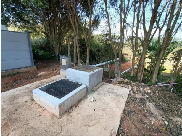
100m<sup>3</sup> 地下污水灌施工及完工现场
