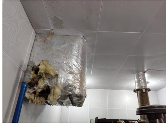
“水喷淋”废气处理设施
