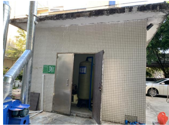
噪声排放源（污水处理站设备房）
