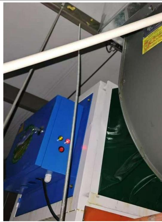
废气处理设施“静电油烟净化器”
