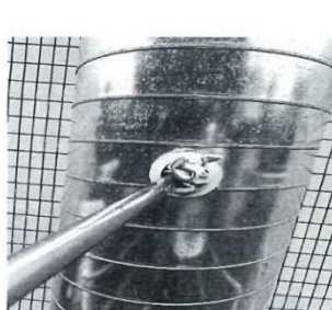
激光切割废气处理后排放口
